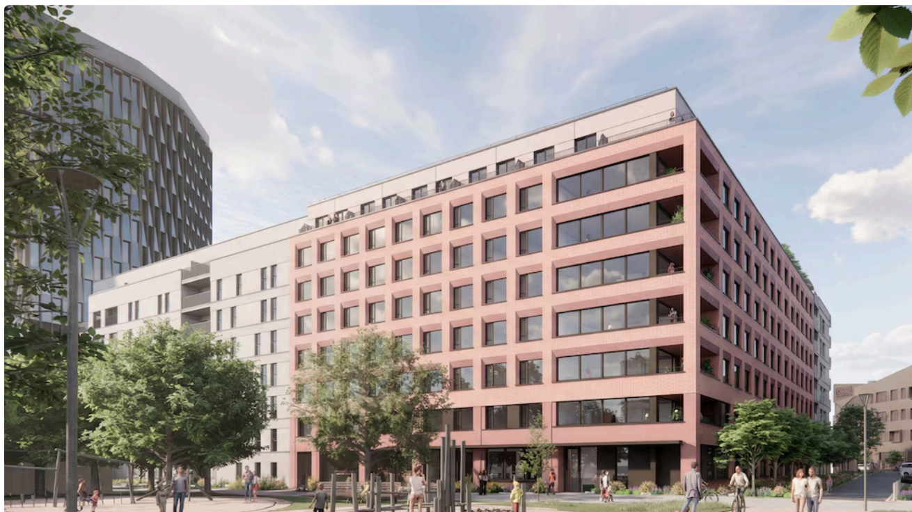
Cette année, Atélia participe à la construction de 252 kots étudiants sur le site de Bavière, à Liège. ©DR
